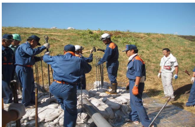
月の輪工法 実習 2
