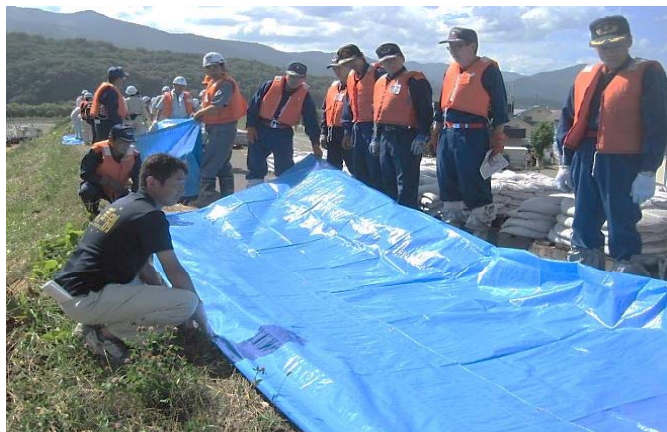
積み土のう工（省力型）実習 1
