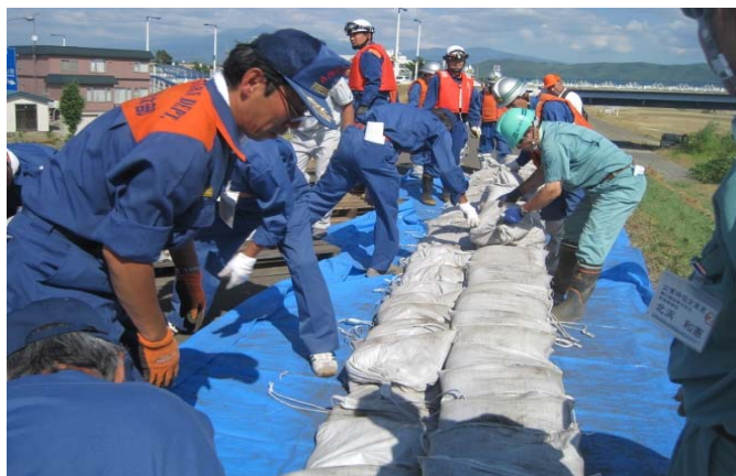
積み土のう工（省力型）実習 3
