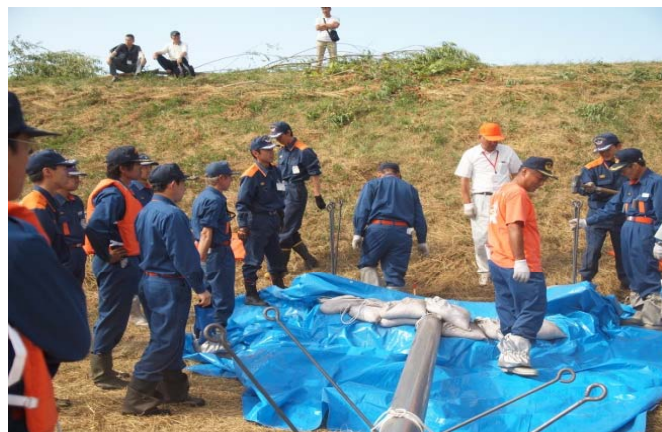
月の輪工法 実習 4
