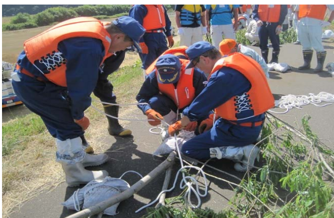
木流し工法 実習 4
