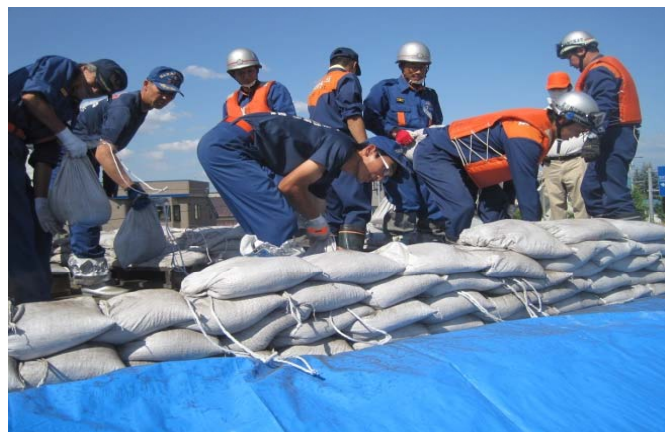
積み土のう工（省力型）実習 2
