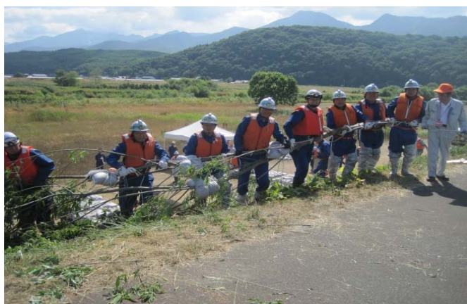
木流し工法 実習 2
