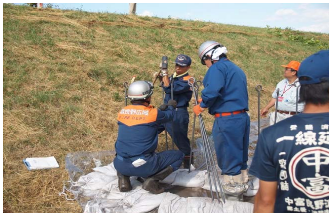
月の輪工法 実習 3
