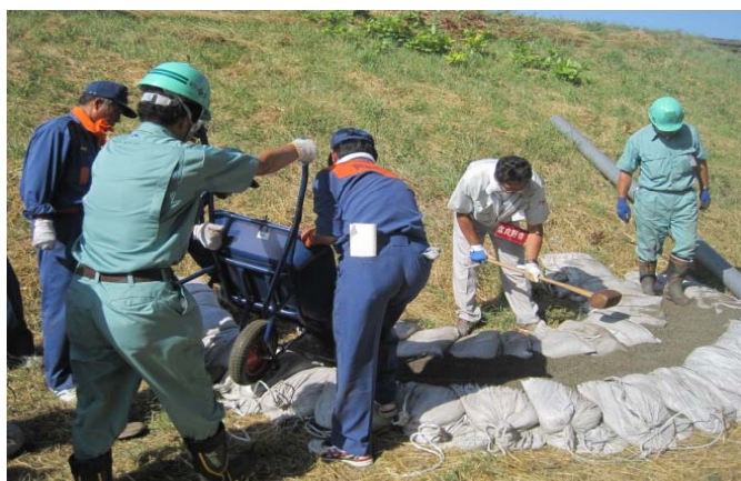
月の輪工法 実習 1
